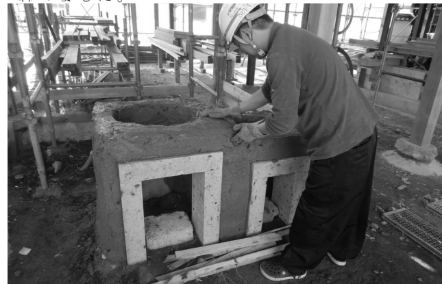
6. カマドの製作 1階土間奥の部屋にカマドを復原整備しています。
