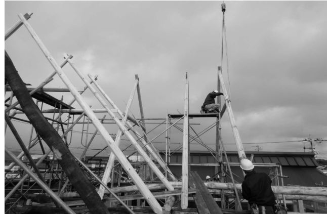
3. 屋根の組立 茅葺屋根下地の扱首（サス、合掌）を組みました。
