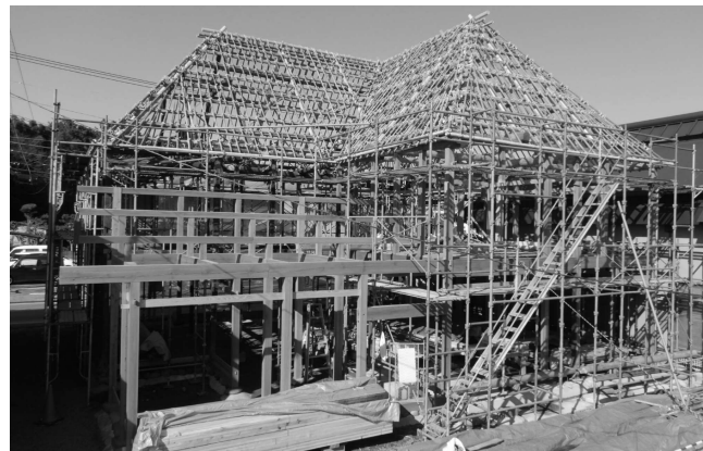
5. 軸組、屋根組完了 油屋の骨格が出来上がりました。
