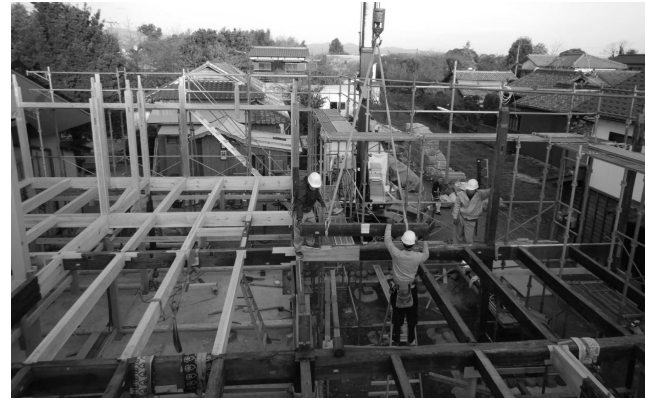
2. 軸組（構造的な部材）の組立 再用する部材は元の位置に、修理取替や復原で補足する部材と共に組み立てました。
