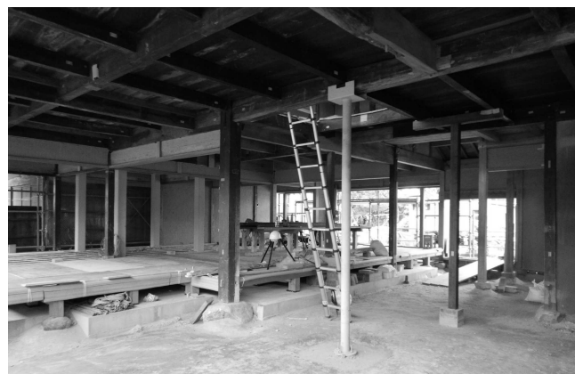
7. 1階内部 2階床組や土壁が塗られ、内部も出来上がってきました。
