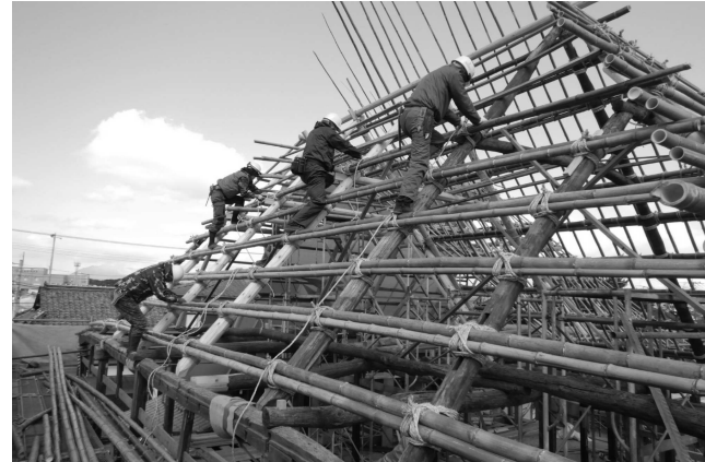
4. 茅葺屋根下地の竹組み 茅葺屋根の下地竹は従来の工法に倣ってわら縄で締めました。
